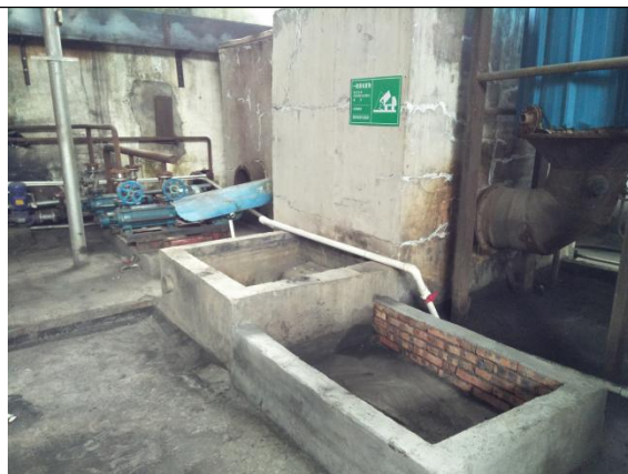
生物质炉渣暂存区
